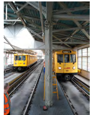
Abb. 4: Genietete Winkelstütze, Grundwerkstoff G04, Foto: Metallbau Adamczyk GmbH
