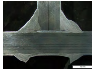
Abb. 27: Dauerschwingprobe FAT 36 mit Riss, Schliff, Foto: SLV Halle
